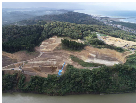
現場全景(完成時)
